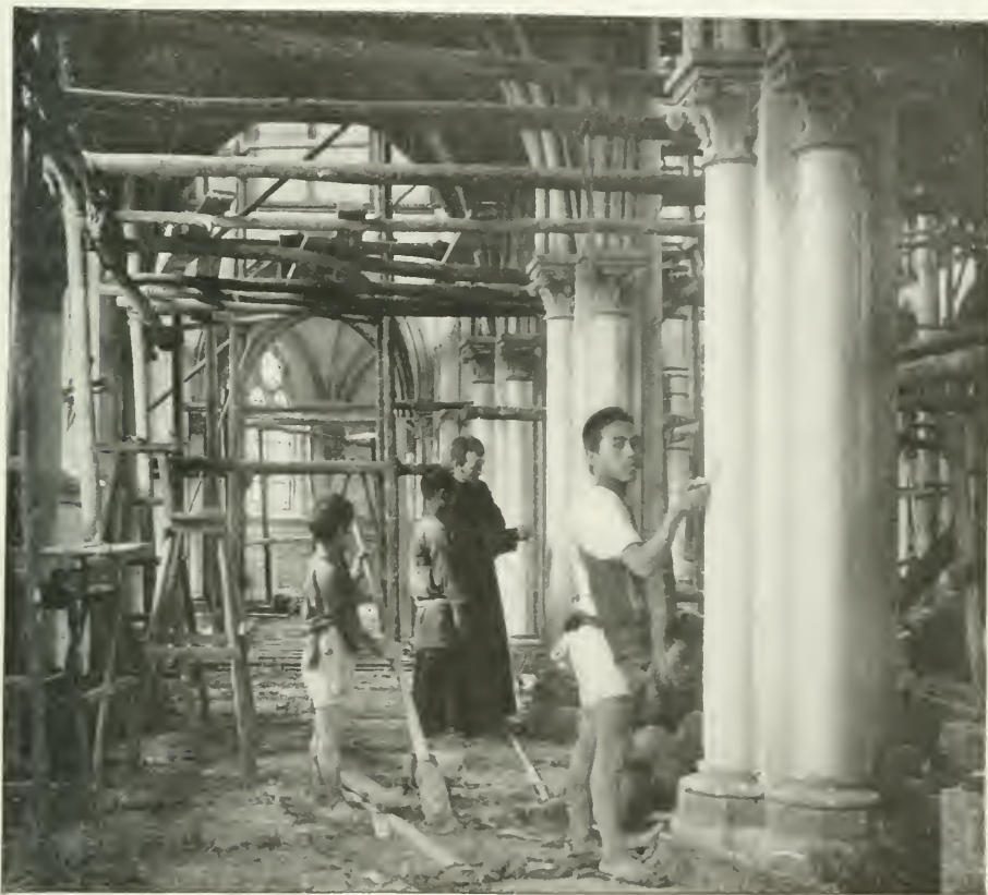
ÉCOLE PROFESSIONNELLE DE TOKIO. — ÉLÈVES TRAVAILLANT A LA CONSTRUCTION DE L'ÉGLISE
